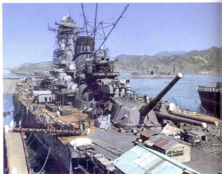
«Ямато» во время постройки
